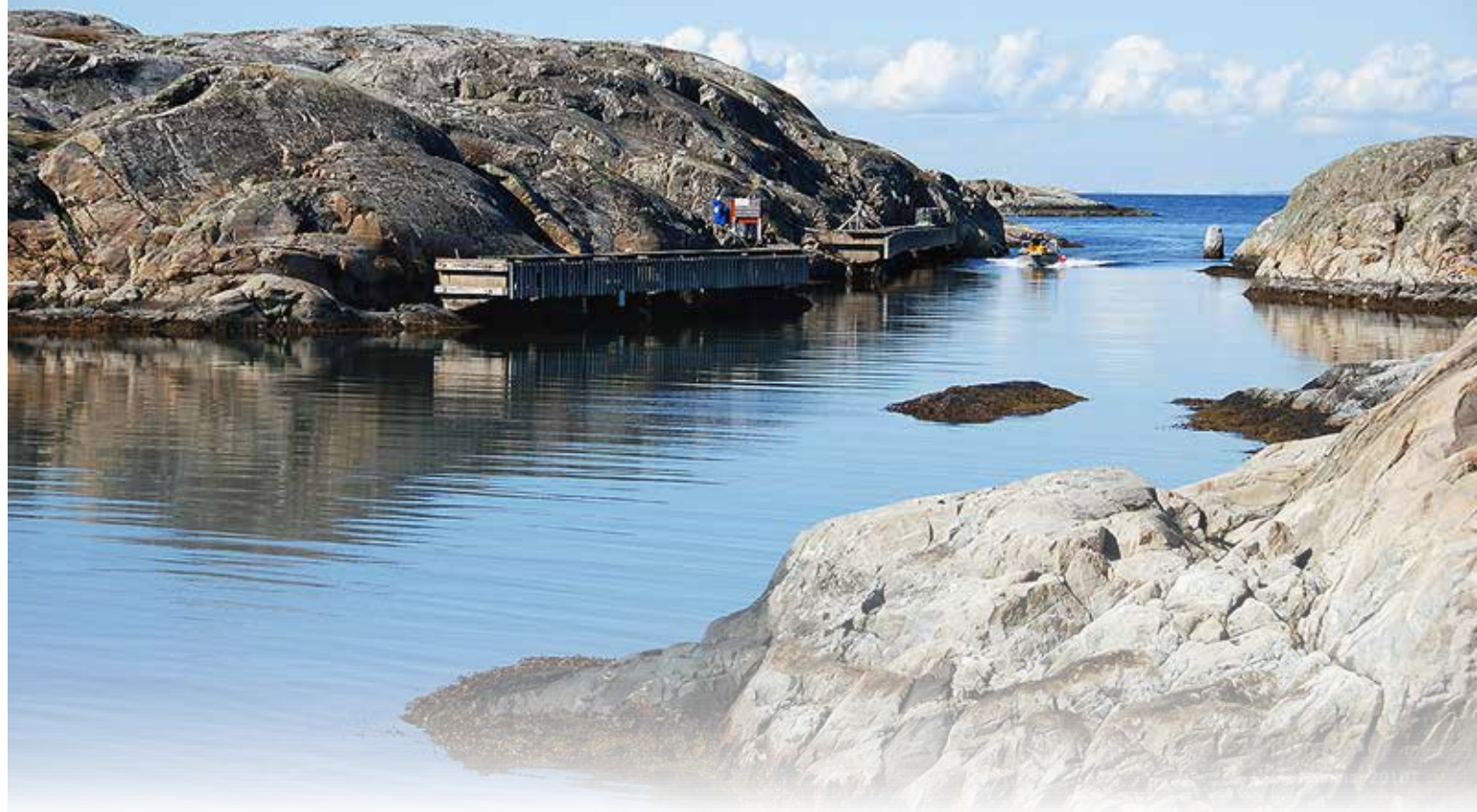
Figur 3.9. Betongkajerna på Stora Hejen, mot nordväst. Kajerna uppfördes enligt uppgift på 1940-talet. Att döma av hamnkulturlagrets utbredning på botten av sundet var det också här man huvudsakligen låg med sina skepp på 1600- och 1700-talen. Foto Lars-Erik Hammar, Bohusläns museum.
